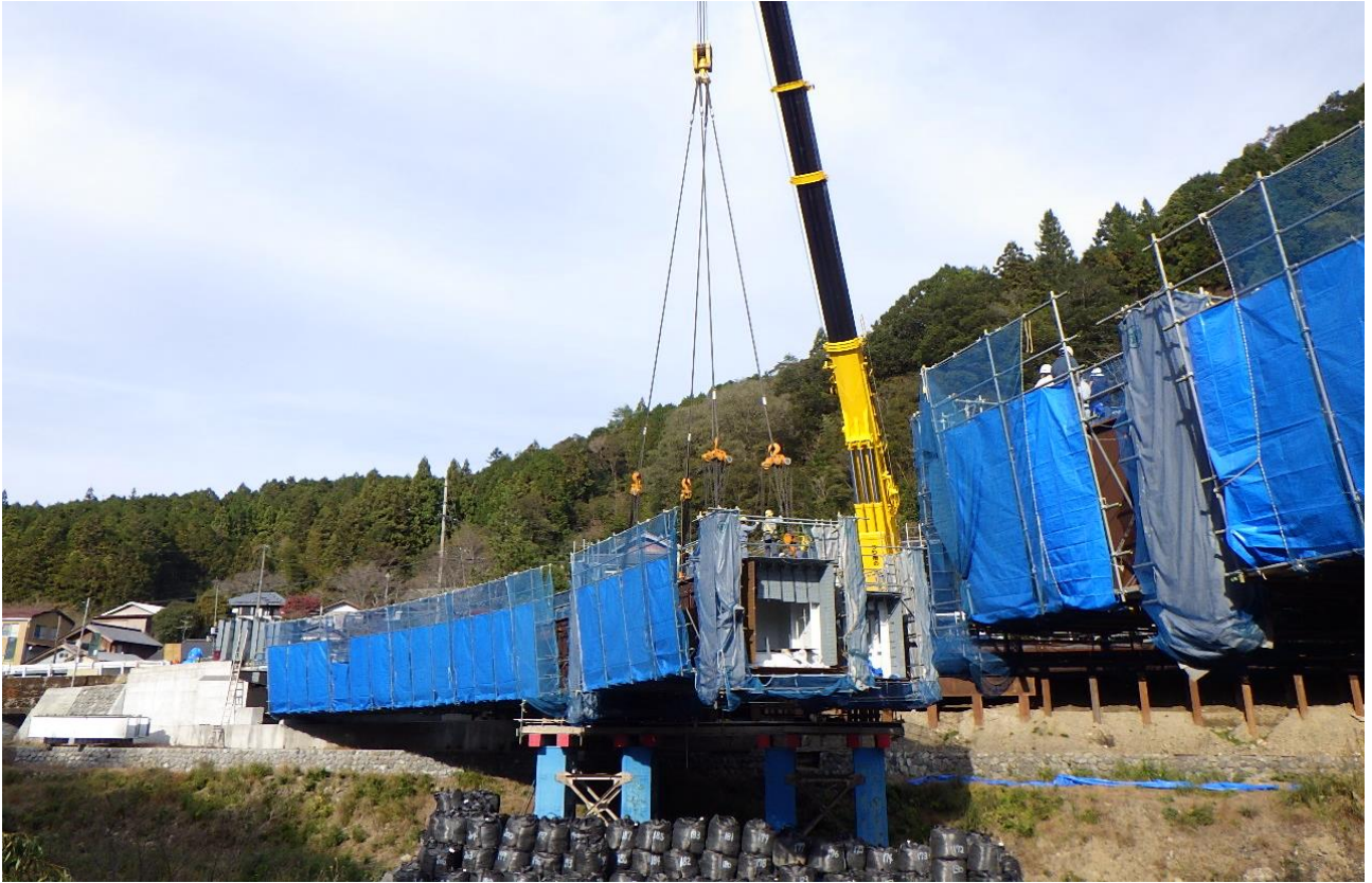
桁架設状況③
