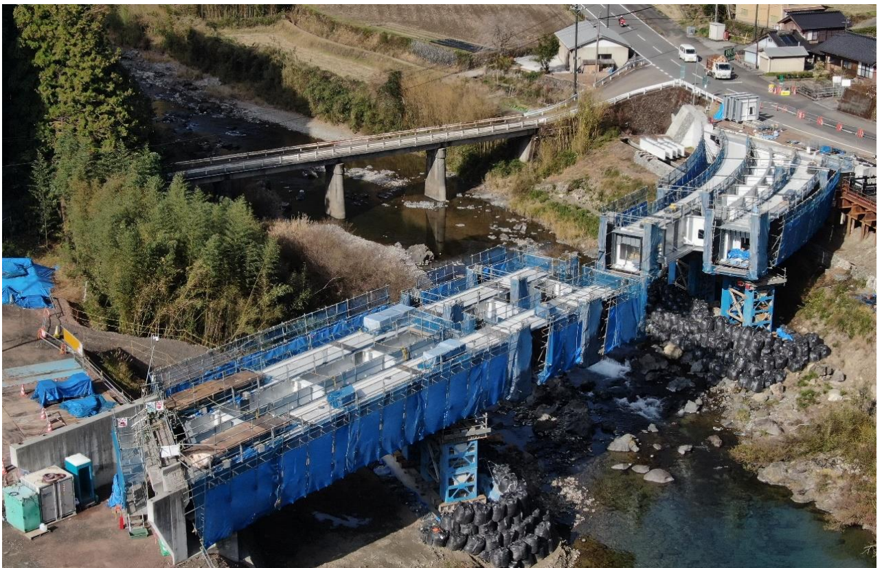
本日の架設完了
