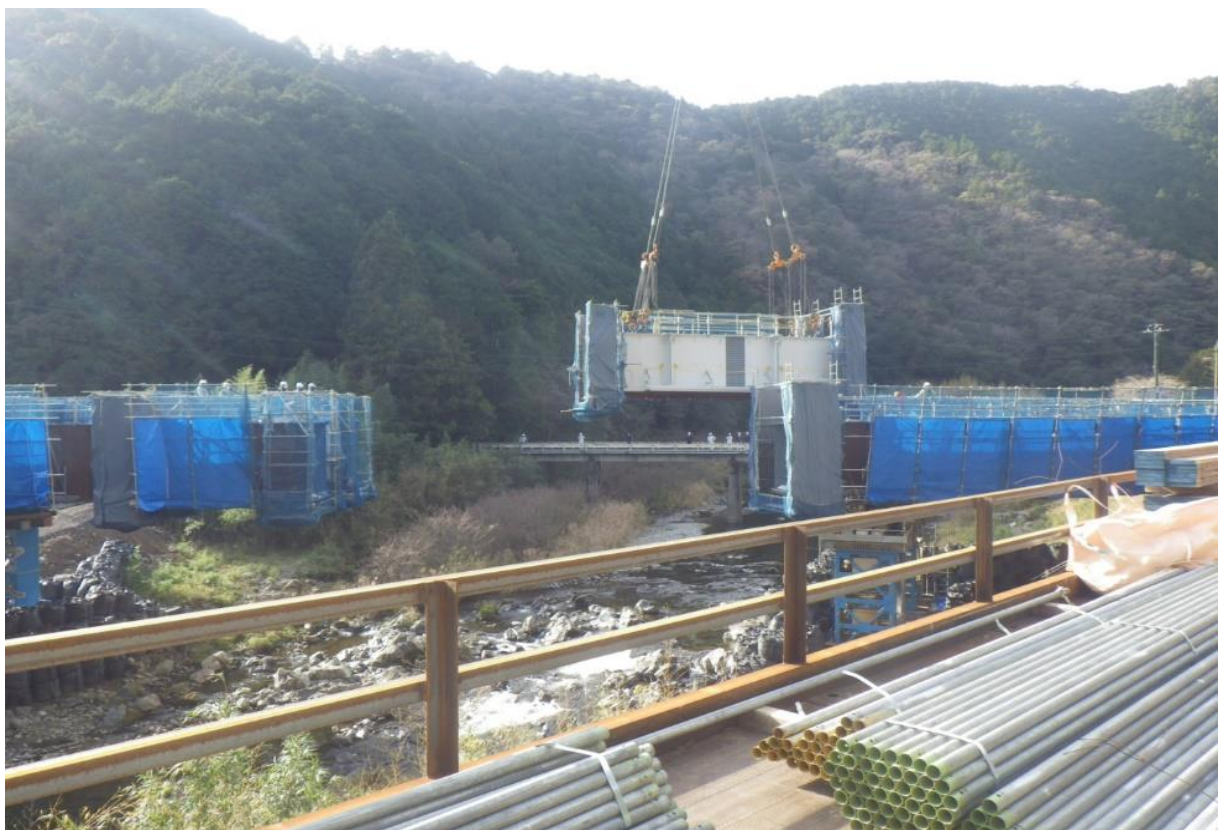
桁架設状況②
