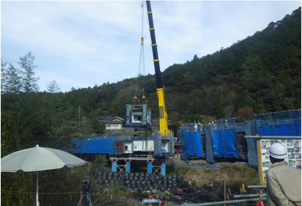
桁架設状況①
